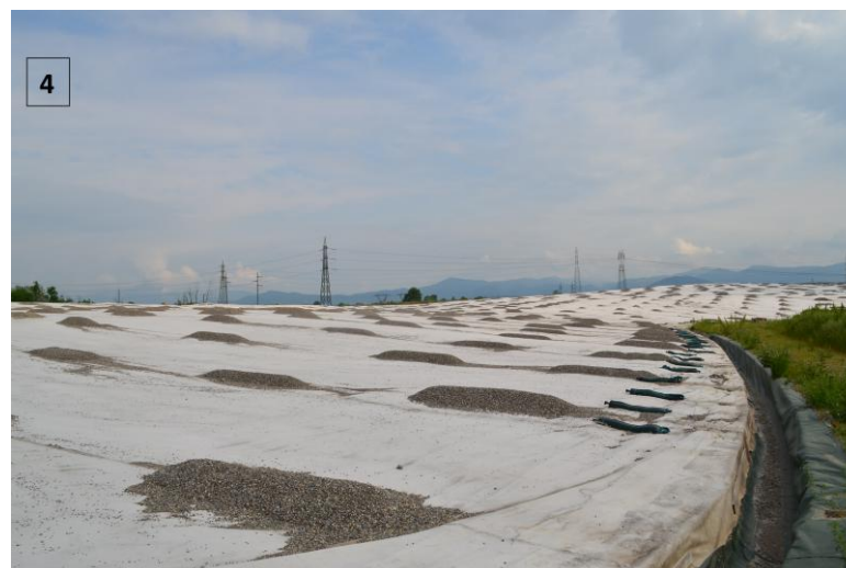
FASE 2 Recupero Ambientale argilla, posa LDPE e TNT
